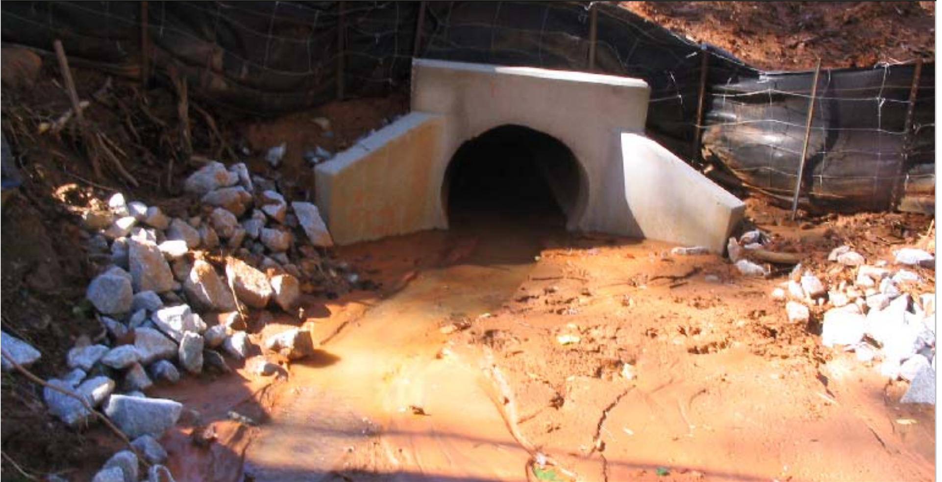
**Después de una gran lluvia inspeccionar si existe erosión y piedras sueltas**
